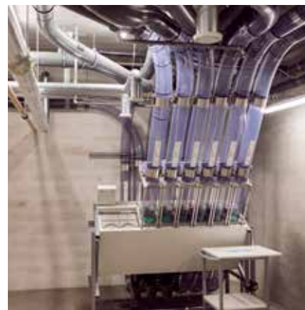
Automatisering. Rørpost sender blodprøver og andet rundt i hele sygehuset.
